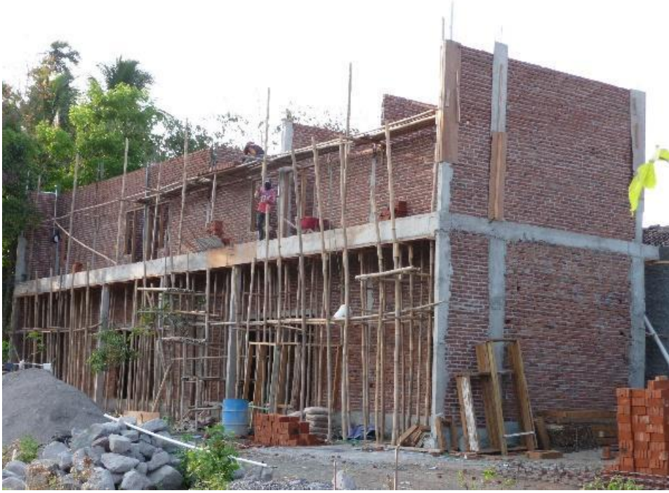
تصویر (۲): ایک زیر تعمیر محصور چٹائی (confined masonry) والی عمارت۔
