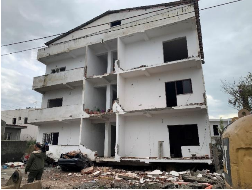
تصویر (۴): اس مکان کی سب سے نچلی منزل کمزور / پگھ دار تھی، جو ایک درمیانے درجے کے زلزلے میں تباہ ہو گئی۔ (N. Vesho)
