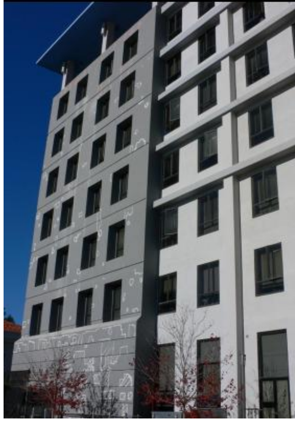
تصویر (۳). اس مکان کے پچھلے حصے میں نسبتاً موٹی ساخت دیکھی جاسکتی ہے، جو پرانے فریم ورک (framework) کے اوپر کنکریٹ کا نیا فریم ورک ہے۔
