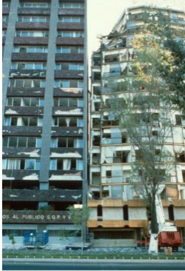
تصویر (۲)۔ زلزلے کے دوران دو مکانوں میں ٹکراؤ ہوا ہے، جن میں سے ایک کو نسبتاً زیادہ نقصان پہنچا ہے۔
