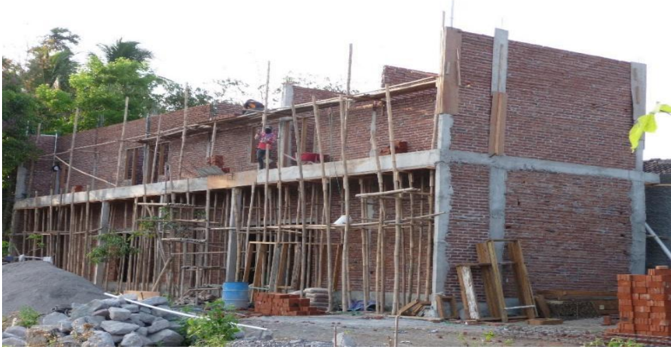
تصویر 3۔ مضبوط کنکریٹ (reinforced concrete) اور اینٹ سے ایک محصور چٹائی (confined masonry) عمارت کی تعمیر۔
