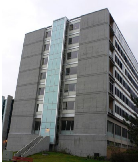
Imaj 2. Yo mete kèk nouvo miray estriktirèl ak fondasyon nan ranfòsman sismik lopital sa a.
