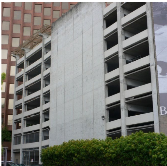
Imaj 5. Yon miray estriktirèl konkrè ki ranfòse reziste a fòs ki aji sou longè bilding nan. Ta dwe gen yon lòt miray sou lòt bò a nan bilding nan.
