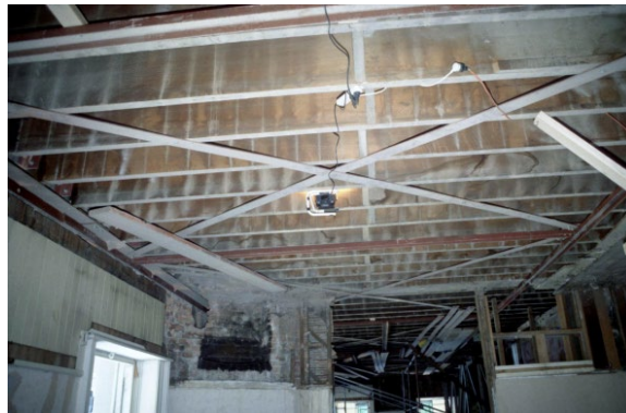
Imaj 5. Yon twati an bwa nan yon bilding masonri ranfòse pou reziste kont tranbleman tèt ak travès asye anba li.
