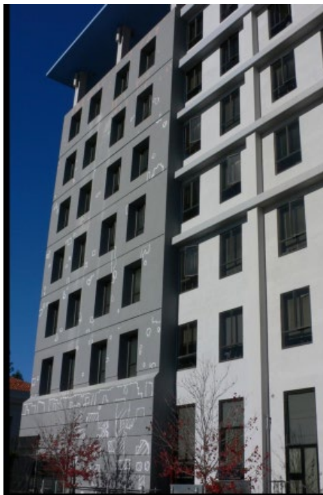
Imaj 3. Konstrikasyon ki pi epè nan bout bilding sa a se yon nouvo kad beton ki mete sou estrikti ki egziste deja pou amelyore pèfòmans pandan tranbleman tèt.
