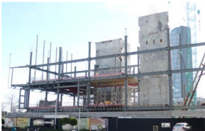
Imaj 3. Yon kay kap kontwi. Pifò fòs tranbleman tèt yo nan tou de direksyon yo reziste pa mi estriktirèl an beton ame. Nan ka sa a, kèk ranfò bay tou pa yon ankadremman an asye ki alantou.
