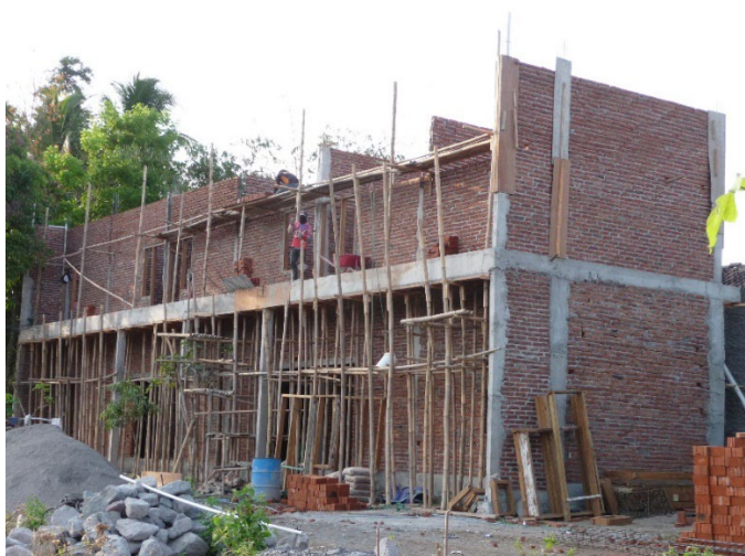
Imaj 3.. Konstriksyon konvansyonèl ki lou ki itilize masori ranfose ak beton ame - nan ka sa a, se konstriksyon an masonry ki sere.
