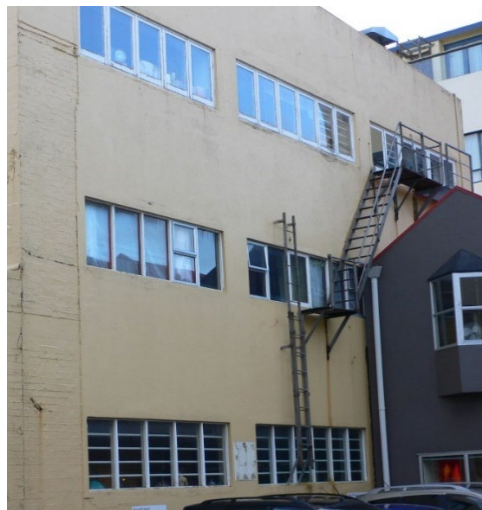
Imaj 2. Kolòn ki gen wotè nòmal yo vin pi kout lè w gade yo nan pèspektiv rezistans kont fòs orizontal, akòz mi ranplisay ki pa rive nan tout wotè etaj la.
