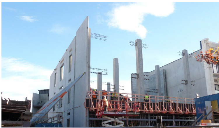
Imaj 2. Bilding sa a gen egzanp avanse sou itilizasyon beton prefabrike.
