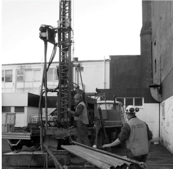
Imaj 3. Yon machin ki fouye pou pran echantiyon tè pou fè tè nan yon laboratwa.
