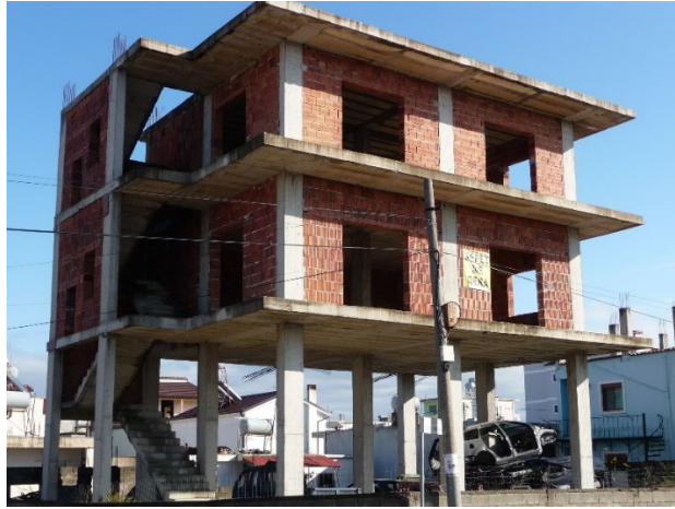
Figure 5. Yon bilding ak etaj mou nou wè anpil kote etaj anba a pi fèb ke lot yo.
