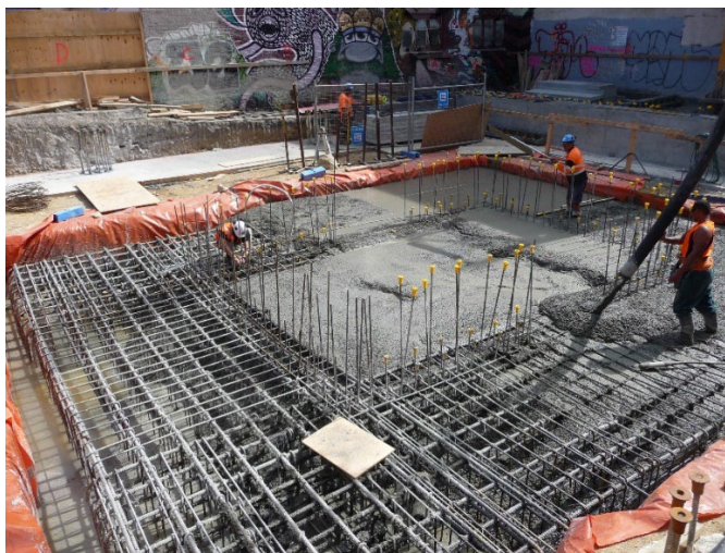
Imaj 3. Fondasyon yon bilding kap konstwi. Enjenyè yo swiv kòd yo pou kalkile kantite fè yo bezwen ak pozisyon kòrèk yo.
