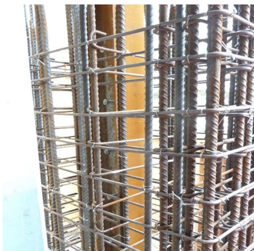
Imaj 3. Ranfòsman nan kolòn yo vizib anvan yo koule beton an. Ranfòsman sa a fèt ak ba vètikal ki kap anpeche yo pliye, ansanm ak etriye orizontal ki anpeche beton kolòn nan kraze epi kite asye nan poto a.
