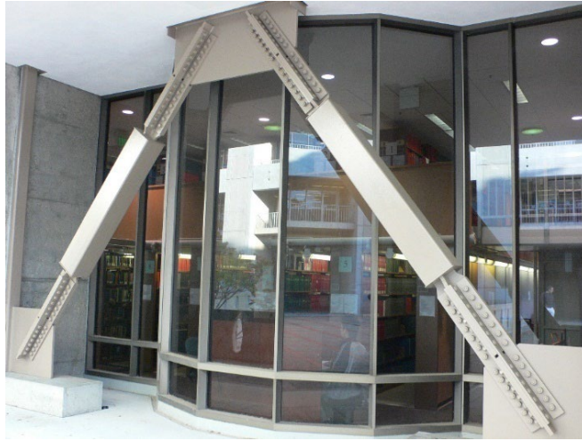
Imaj 5. De travès dyagonal ki rete tenn fas, yo la pou reziste epi diminye mouvman pandan tranblemann tè.
