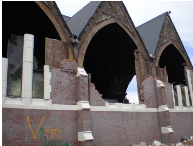
Imaj 4. Tranblemann tè a domaje anpil fasad brik ak vit ki nan bilding sa a.
