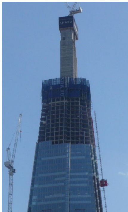
Imaj 3. Yon egzanp yon sant an beton ame pandan konstriksyon yon bilding.
