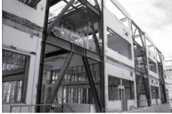
图 22-4 在加固过程中，这座建筑中插入了几个钢支撑
