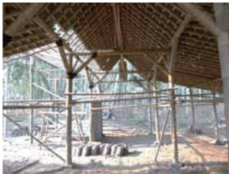
图 9-1 采用当地传统材料和建造技术的新建建筑，在水平方向较柔
