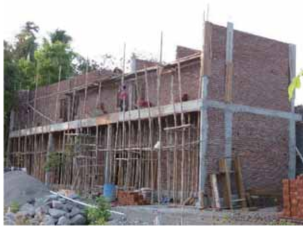
图 5-2 正在建造的约束砌体结构
