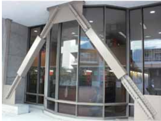
图 23-5 两个防屈曲支撑在地震中抵抗地震作用并减小侧移
