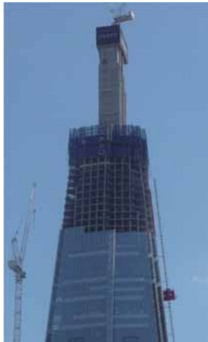
图 14-3 在建建筑中的钢筋混凝土核心的示例
