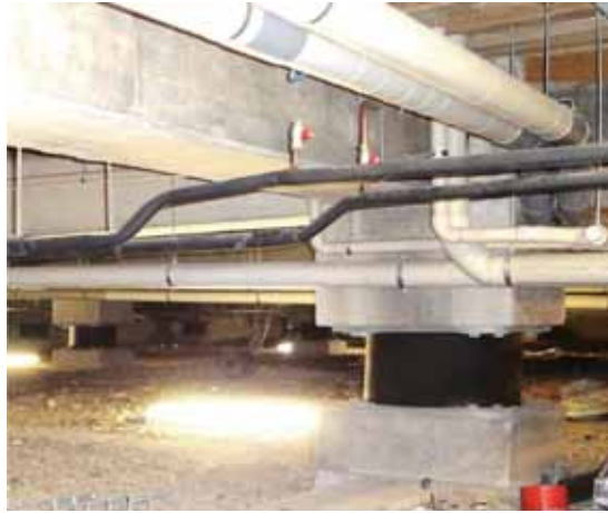
图 23-2 建筑下面的两个黑色的圆柱形隔震支座。每个支座都用螺栓固定在混凝土基座上，混凝土基座连接到地基和一根支撑上部结构的柱底部
