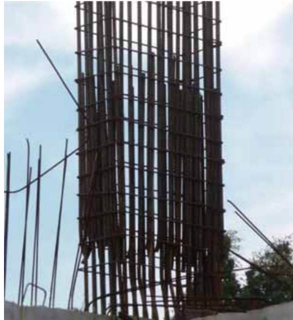
图 20-2 这个柱子的钢筋在许多方面都不符合当地的规范和标准。 在中到大地震中，它将受到严重破坏
