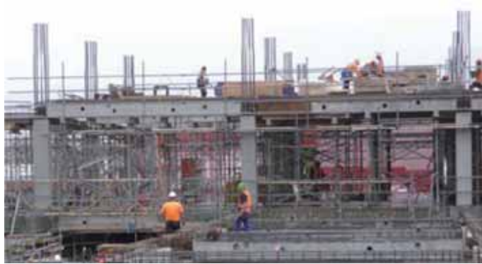
图 20-3 工程师需要定期到施工现场检查，以确保施工符合计划和规范
