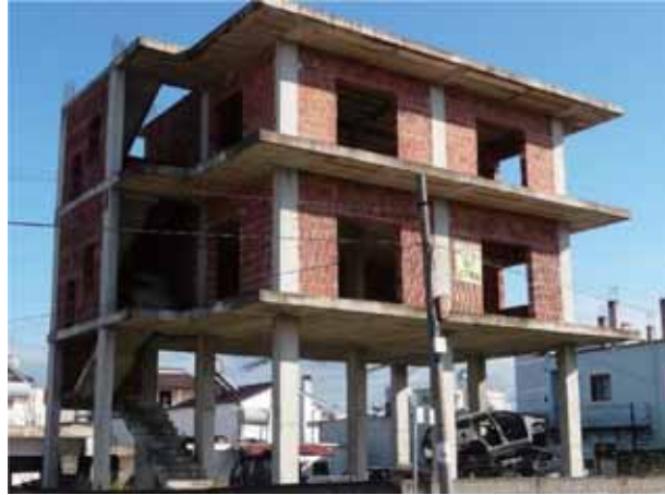
图 11-5 一栋典型的底层为薄弱层的建筑
