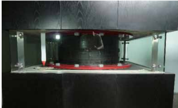
图 18-4 位于每根柱子的底部和基础之间，包含许多薄钢板的圆形橡胶支座，隔离建筑免受水平地震震动的影响
