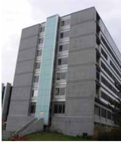
图 22-2 这座医院大楼的抗震加固改造包括在每一端增设两道新的结构墙和基础
