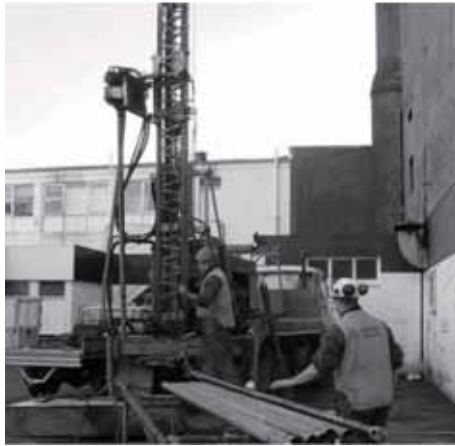
图 2-3 钻机正在采样
