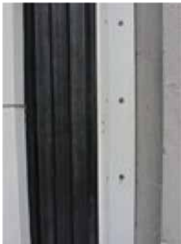
图 15-5 覆盖防震缝的防水板细节图
