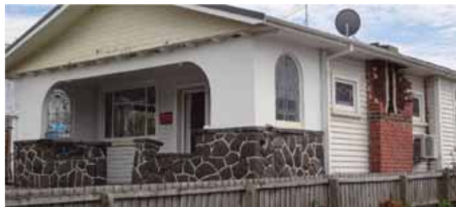
图 21-3 砖烟囱在屋顶处断裂并倒下。剩余的大部分烟囱受损 (N. Allaf)
