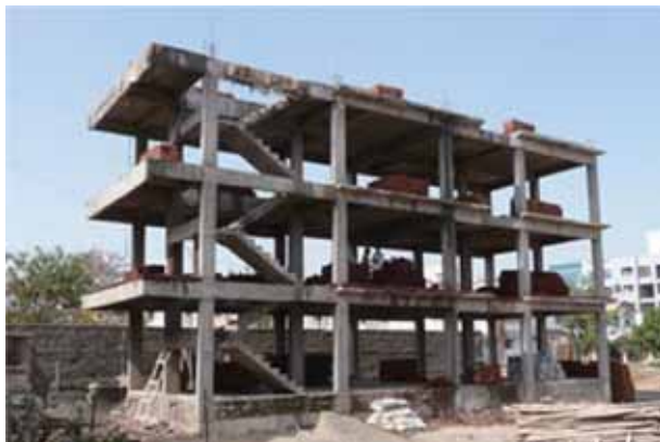
图 8-2 钢筋混凝土楼板将梁和柱连接在一起，使得同一层内所有构件地震时整体水平移动
