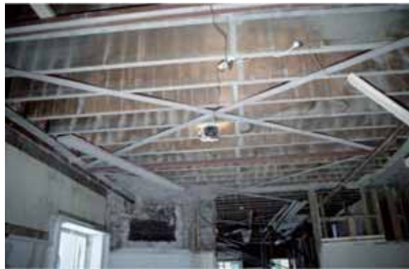
图 22-5 通过在砌体结构的木地板下面设置钢支撑来提升抗震性能
