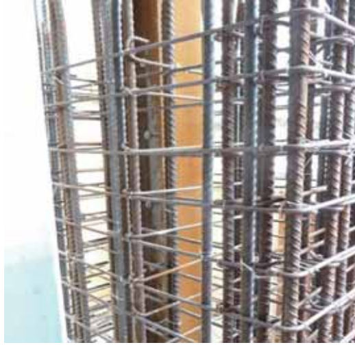
图 6-3 在浇筑混凝土之前，可以看出柱内的钢筋由抗弯曲的垂直钢筋和防止柱混凝土压溃的水平箍筋绑扎组成
