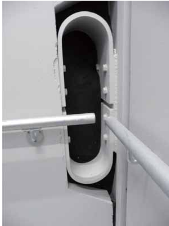
图 23-7 位于两堵摇摆墙之间的耗能元件
