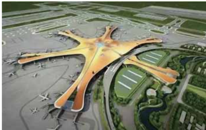
图 18-3 采用基础隔震的北京大兴机场
