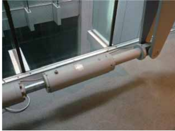
图 23-3 一个用来减少建筑地震中振动的阻尼器
