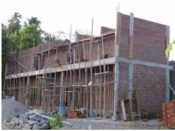
图 9-3 采用砖石和钢筋混凝土的传统建筑，并采用约束砌体墙
