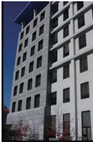
图 22-3 这座建筑末端的较厚结构是在现有结构上浇筑的新混凝土框架，用于提高抗震性能
