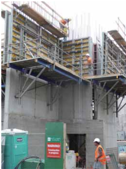
图 19-2 在设计和施工期间，工程师检查了这些钢筋混凝土墙，以确保结构设计合理，且施工符合计划
