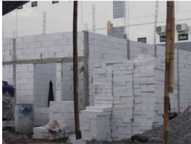
图 17-3 建筑法规需要指定新材料安全且实用的使用方法， 比如这些轻型砌块
