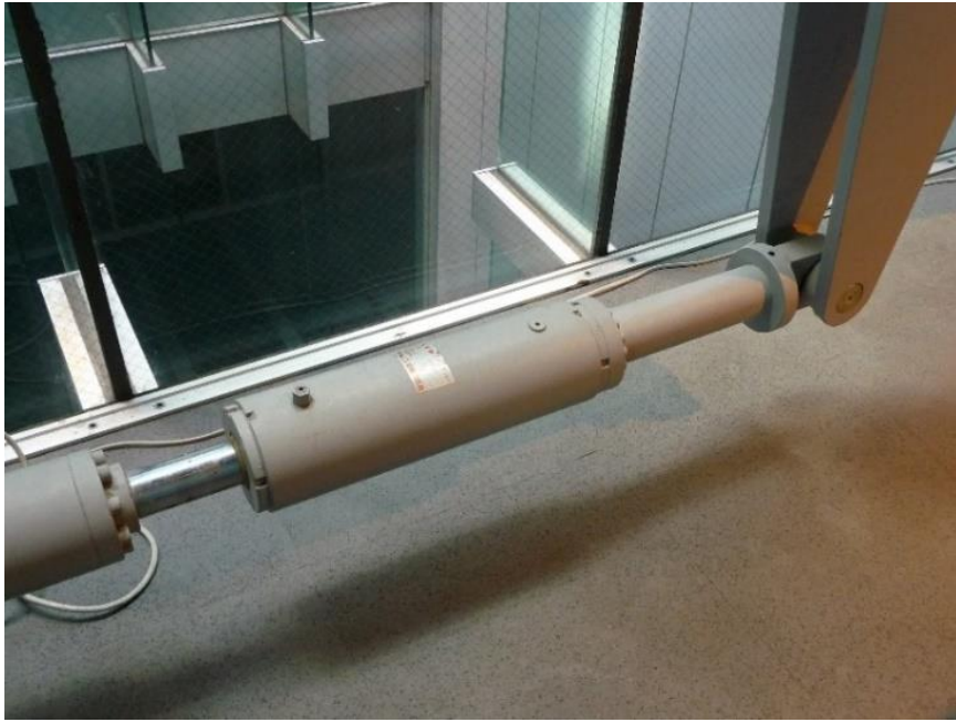
Gambar 3. Peredam untuk mengurangi gerakan bangunan akibat gempa.
