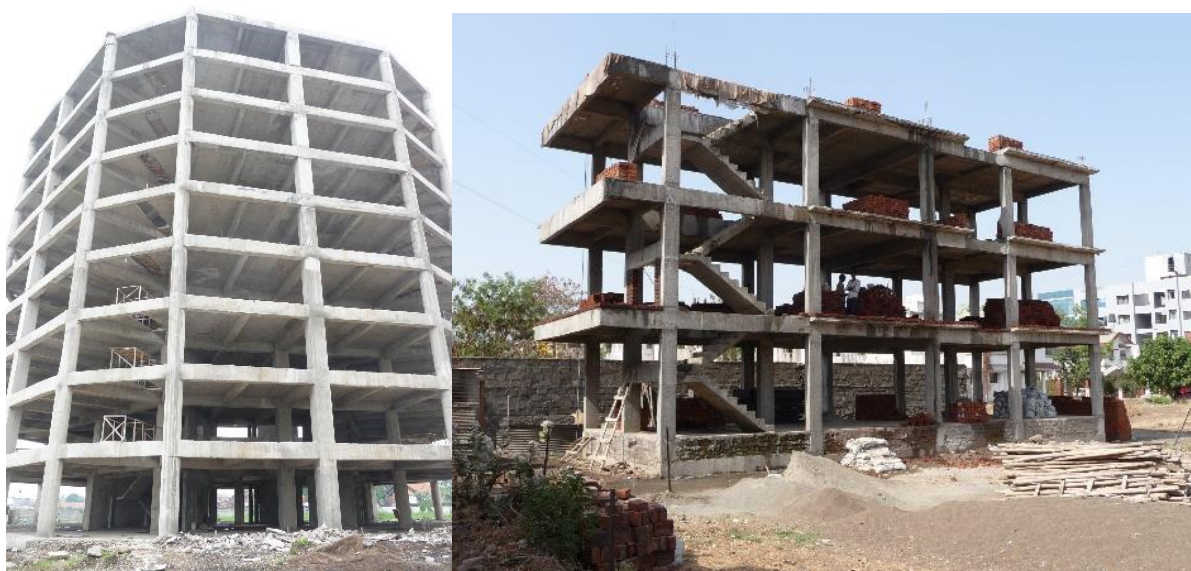
Gambar 1. Bangunan sistem rangka menahan gempa melalui kekuatan kolom dan balok. Dinding dan penutup eksterior (cladding) belum dibangun.
