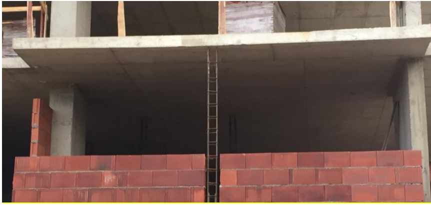
Gambar 4. Contoh kolom praktis untuk menstabilkan dinding pasangan bata (S.Brzev).
