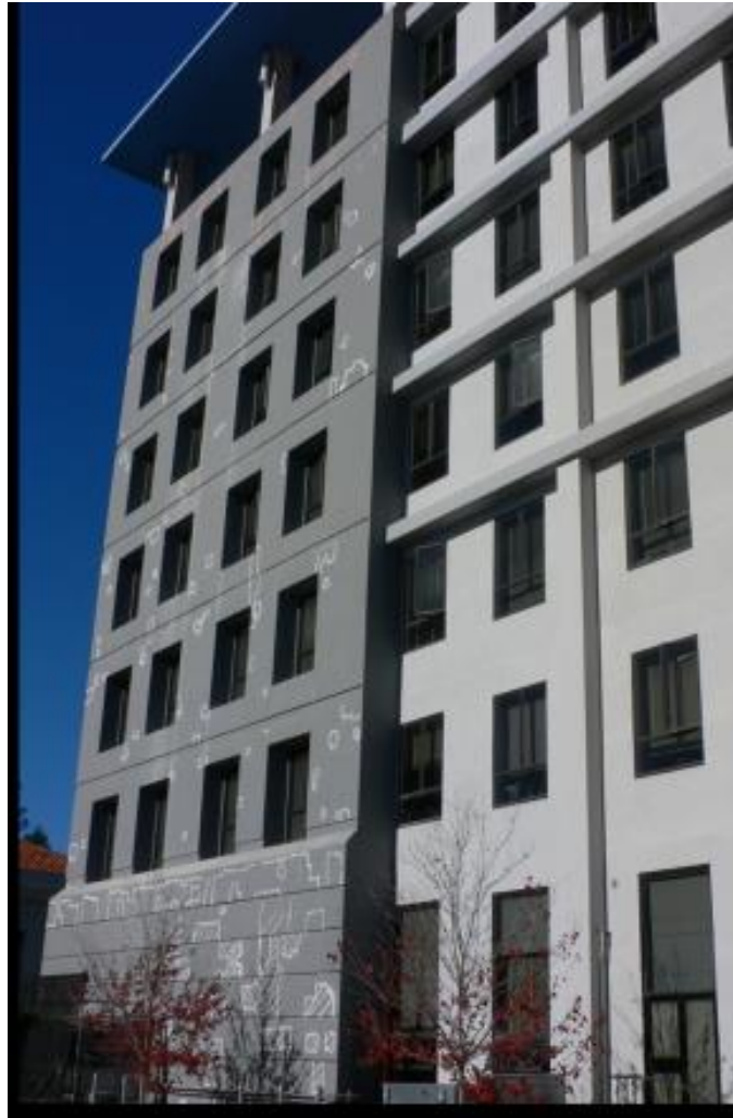
Gambar 3. Konstruksi yang lebih tebal di ujung bangunan ini adalah rangka beton baru yang dipasang pada struktur eksisting untuk meningkatkan kinerja terhadap gempa.
