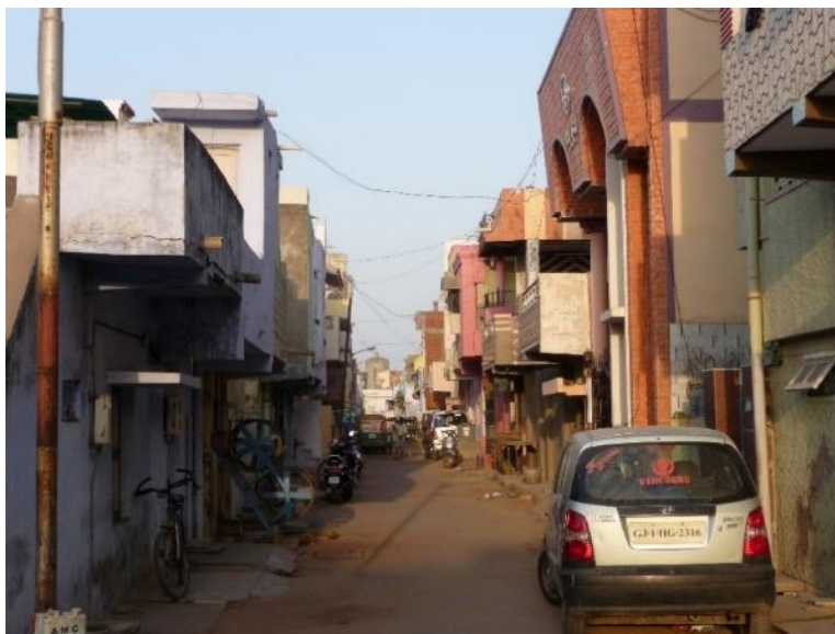
Gambar 2. Bangunan-bangunan dengan dinding pengisi tak menerus tampak di sepanjang jalan.
