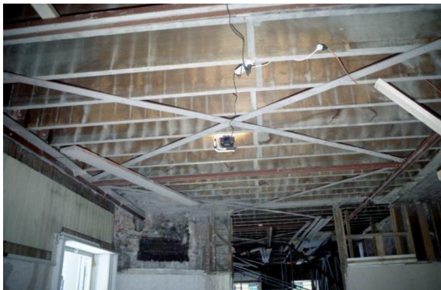
Gambar 5. Beis baja dipasang di bawah lantai kayu dari bangunan pasangan bata untuk menahan gempa.
