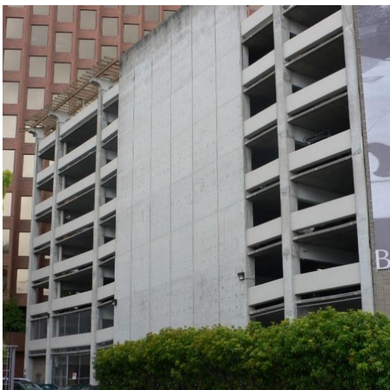
Gambar 5. Dinding struktural beton bertulang menahan gaya dalam arah memanjang gedung. Dinding serupa juga digunakan pada sisi lain gedung.
