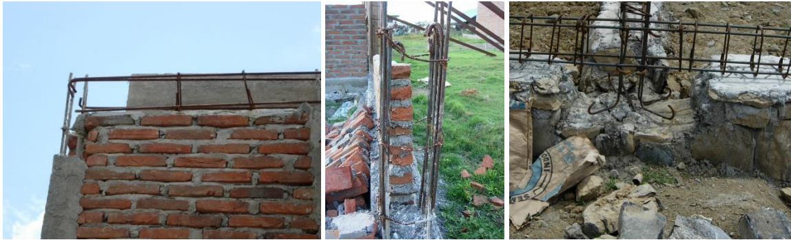
Gambar 2. Pembuatan kolom dan balok yang kurang baik: (a) Sambungan balok kolom yang kurang baik karena tidak adanya panjang penyaluran yang cukup untuk tulangan, (b) Detail penulangan yang kurang baik karena penggunaan tulangan polos, diameter tulangan yang terlalu kecil, jarak sengkang yang terlalu jauh, dan tidak adanya kait seismik, (c) Sambungan kolom ke fondasi yang tidak sesuai standar.
