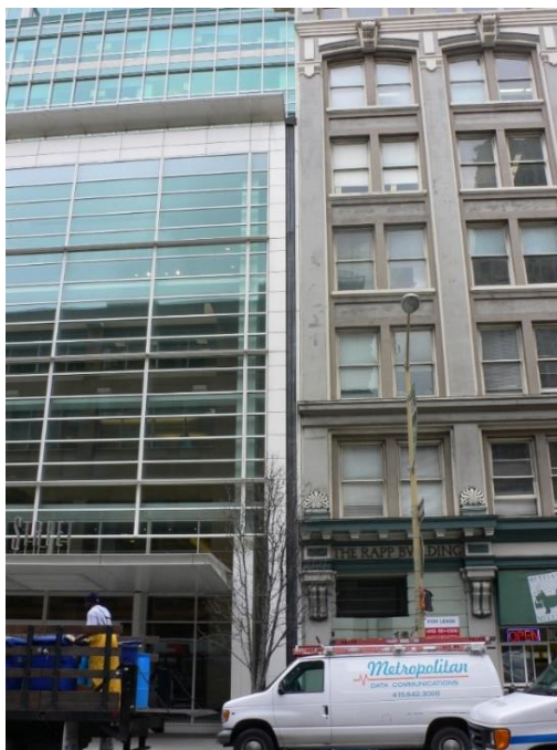
Gambar 4. Dua bangunan yang dipisahkan oleh celah seismik, yang ditutupi oleh pelat tipis yang fleksibel.
