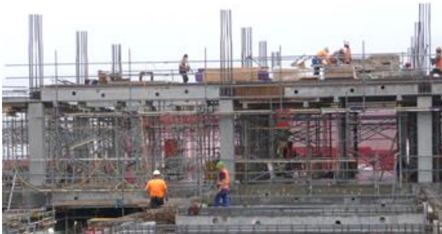
Gambar 3. Insinyur perlu meninjau lokasi konstruksi secara berkala untuk memastikan konstruksi sesuai dengan gambar rencana dan spesifikasi
