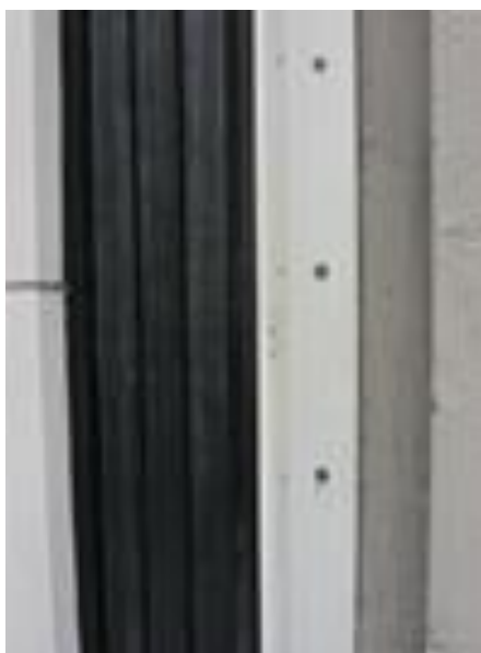
Gambar 5. Tampak dekat dari pelat tipis yang menutupi celah seismik.
