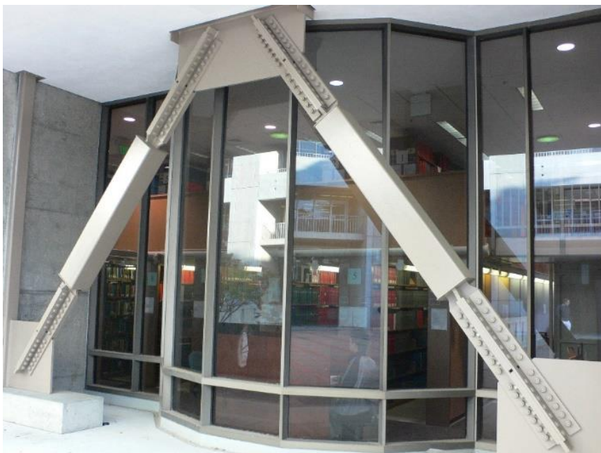
Gambar 5. Dua breis tahan-tekek ( buckling-restrained braces ) menahan dan meredam gerakan bangunan saat gempa.
