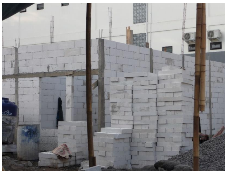
Gambar 3. Peraturan bangunan perlu menentukan cara yang aman namun praktis dalam penggunaan material baru, seperti bata ringan ini.
