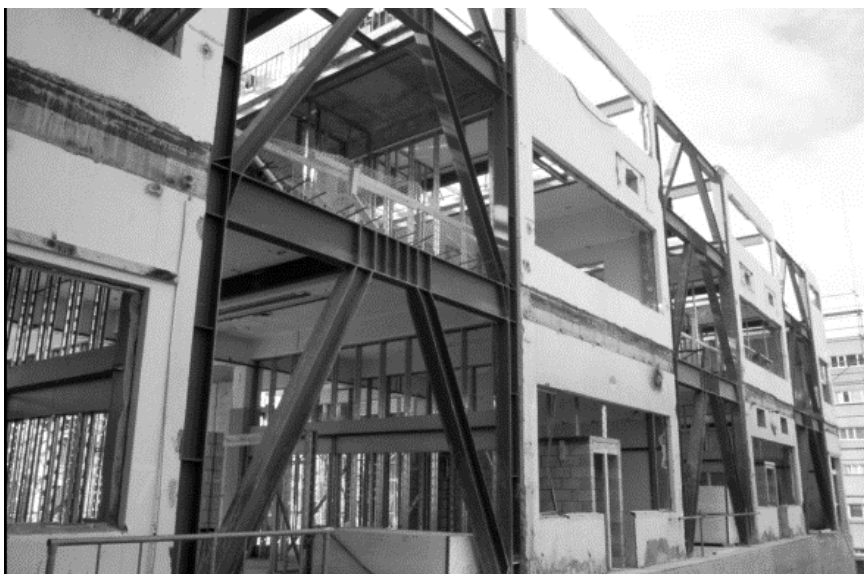
Gambar 4. Bentang-bentang breis baja ditambahkan pada bangunan sebagai bagian dari retrofit.
