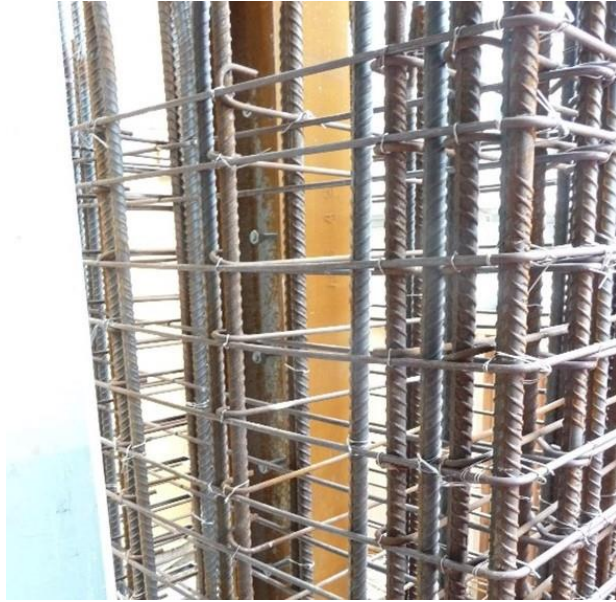
Gambar 3. Tulangan kolom terlihat sebelum dicor. Tulangan terdiri dari tulangan vertikal yang menahan lentur, dan sengkang horizontal yang mengikat beton kolom agar tidak hancur dan terlepas.
