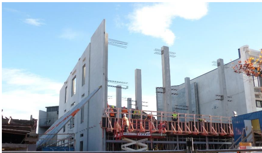
Gambar 2. Bangunan ini memperlihatkan contoh inovasi berupa penggunaan beton pracetak.
