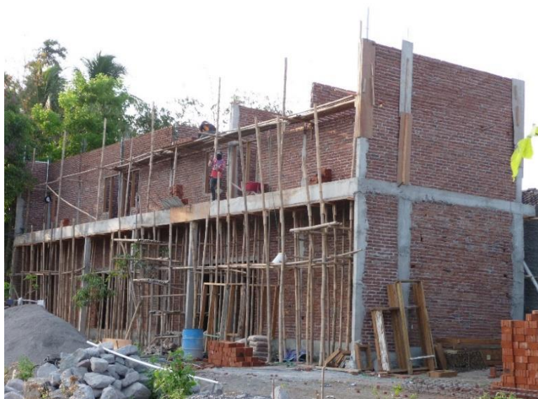
Gambar 3. Konstruksi sistem dinding bata terkekang menggunakan beton bertulang dan bata yang relatif berat.
