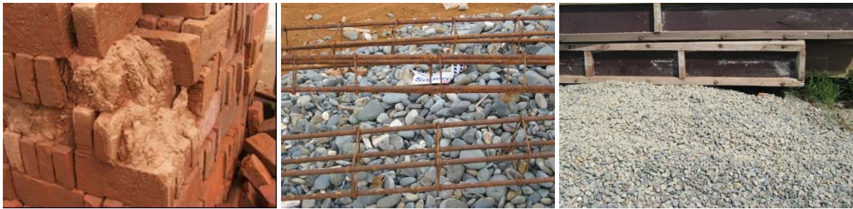
Gambar 3. Penggunaan material konstruksi yang kurang baik akan menghasilkan kualitas bangunan yang kurang baik pula
