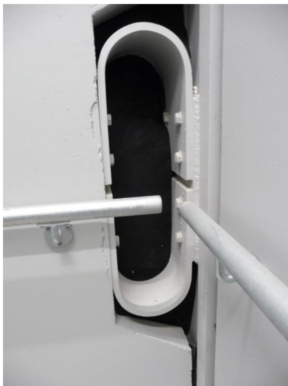
Gambar 7. Pelat baja sebagai perangkat penyerap energi gempa yang terletak di antara dua dinding beton yang bergoyang.
