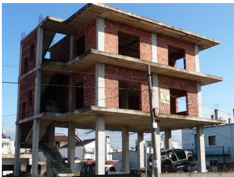
Gambar 5. Tipikal bangunan dengan tingkat lunak, dimana lantai dasar adalah yang terlemah.
