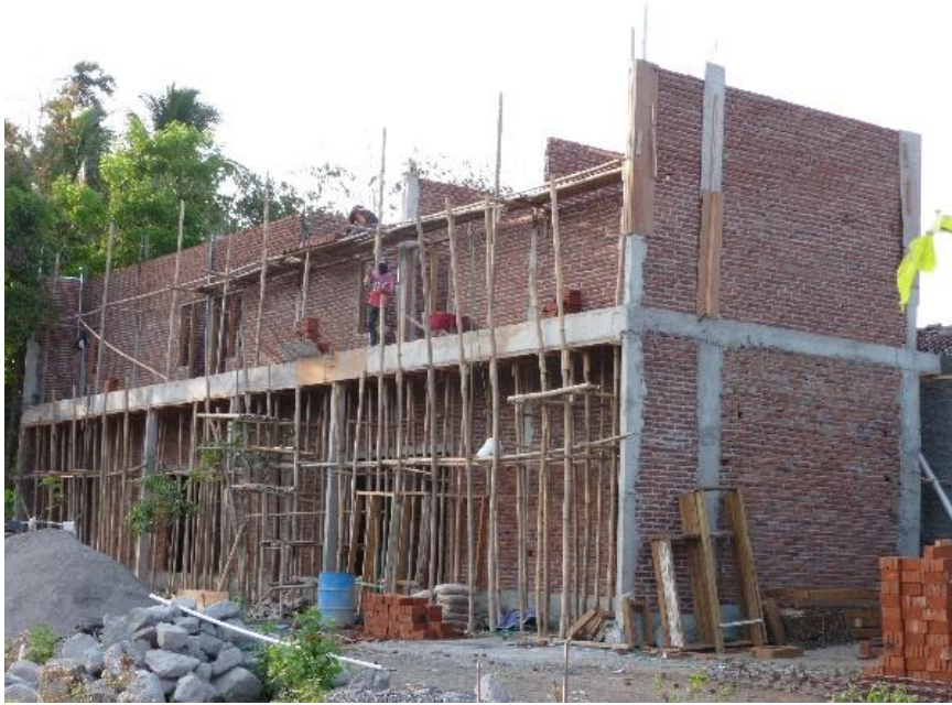
Gambar 2. Rumah menggunakan sistem bata terkekang dalam tahap konstruksi
