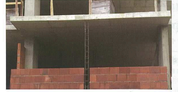
চিত্র ৪. একটি গাঁথনি প্রাচীর (S.Brzev) স্থিতিশীল করার জন্য একটি মধ্যবর্তী কলামের একটি উদাহরণ।
