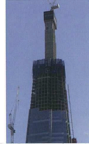
চিত্র ৩. নির্মাণাধীন একটি ভবনে রি-ইনফোর্সড কনক্রিটে তৈরি স্তম্ভের নমুনা
