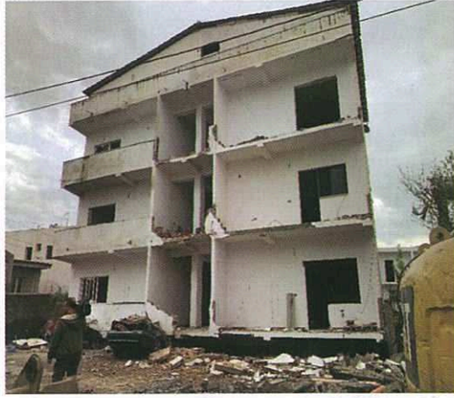
চিত্র ৪. একটি মাঝারি ভূমিকম্প (N. Vesho) এই নরম গল্পের বিল্ডিংটি তার নিচতলা হারিয়ে ফেলে।
