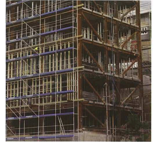
চিত্র ৩. ইস্পাতের তৈরি ব্রেসড ফ্রেম, আড়াআড়ি ভাবে আসা কম্পনের শক্তি থেকে প্রতিহত করে। ইস্পাতের মোমেন্ট ফ্রেম ভবন জুড়ে প্রতিরোধ শক্তি তৈরি করে থাকে।
