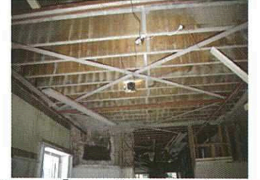
চিত্র ৫. একটি দেয়াল গাঁথুনির ভবনে কাঠের মেঝেতে ভূমিকম্প প্রতিরোধের জন্য এর নিচে ইস্পাত বন্ধনী দ্বারা শক্তিশালী করা হয়েছে।
