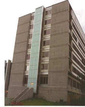
চিত্র ২. এই হাসপাতাল ভবনের পূর্ণবিন্যাস (Retrofitting) এ প্রতিটি প্রান্তে দুটি নতুন কাঠামোগত প্রাচীর এবং ভিত্তি অণুভুক্ত করেছে।
