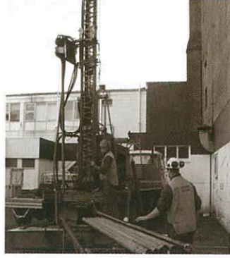
চিত্র ৩. পরীক্ষাগারে পরীক্ষা করার জন্য ড্রিলিং রিগ এর মাধ্যমে মাটির নমুনা সংগ্রহ করা হচ্ছে।
