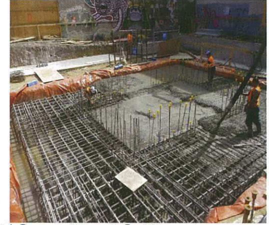
চিত্র ৩. নির্মাণাধীন ভবনের ভিত্তি। প্রকৌশলীরা বিধিমালা অনুসরণ করে এর জন্য প্রয়োজনীয় রেইনফোর্সিং স্টিল এবং সঠিক লোকেশন নির্ধারণ করছেন।
