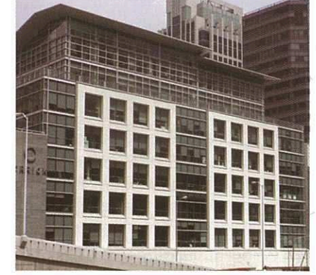
চিত্র ২. দুটি চার-সারি সংকুলিষ্ট মোমেন্ট ফ্রেম ভবনটিকে বরাবর আসা কম্পনের শক্তি থেকে রক্ষা করে। ঠিক একই রকম ফ্রেম, ভবনের এর ওপর পাশেও থাকে।
