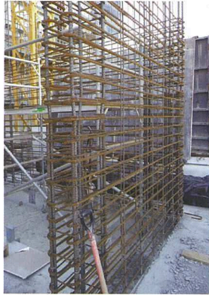
চিত্র ১. একটি ভূমিকম্পের সময় ভবনে গুরুতর ক্ষতি হতে পারে যদি এই রেইনফোর্সড কংক্রিটের দেয়াল থেকে কিছু রেইনফোর্স বার বাদ পড়ে যায়
