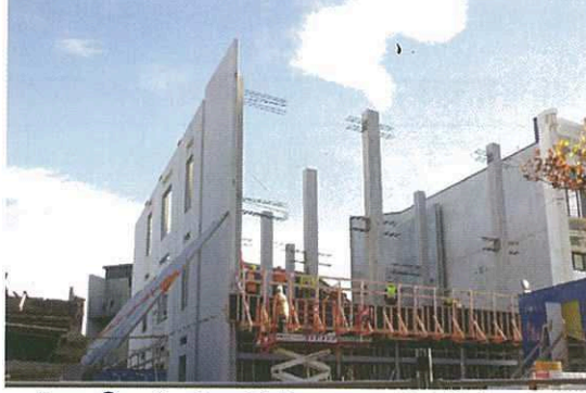
চিত্র ২. এই ভবনটিতে প্রিকাস্ট কংক্রিটের ব্যবহারের উদাহরণ দেখা যাচ্ছে
