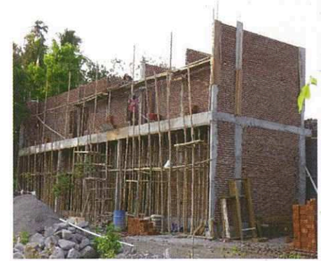
চিত্র ২ঃ একটি কনফাইনড মেশানরি বা আবদ্ধ নির্মাণ প্রক্রিয়া চলমান।
