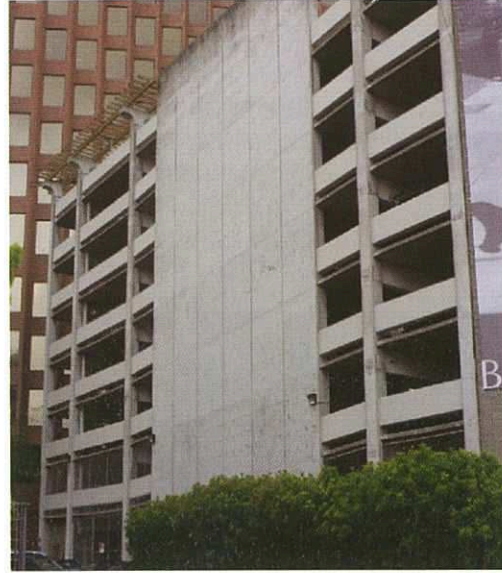
চিত্র ৪. রিইনফোর্সড কংক্রিটের কাঠামোগত দেয়াল, দালানে এর দৈর্ঘ্য বরাবর আসা কম্পনকে মোকাবিলা করে। দালানে এর ওপর পাশেও ঠিক একই রকম একটা দেয়াল থাকে।
