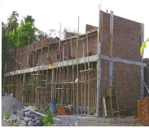
চিত্র ৩. চাঙ্গা কংক্রিট এবং রাজমিস্ত্রি ব্যবহার করে প্রচলিত ভারী নির্মাণ - এই ক্ষেত্রে, সীমাবদ্ধ রাজমিস্ত্রি নির্মাণ।
