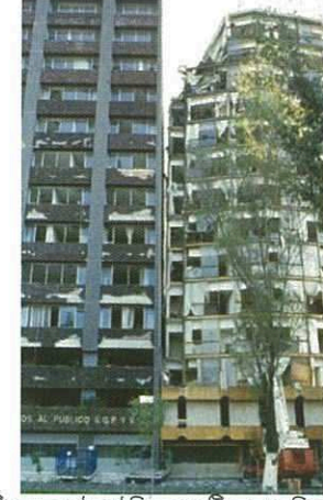
চিত্র ২. দুইটি ভবনের ঠোকাঠুকিতে একটি ভবন বেশি ক্ষতিগ্রস্ত হয়েছে
